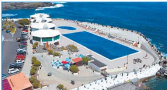
Die Anlage wird umgestaltet und frei zugänglich gemacht (Foto/AyLosSilos)
